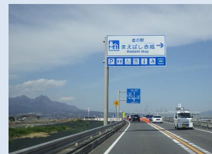
国道17号線標識・区画線配置 (群馬県)
