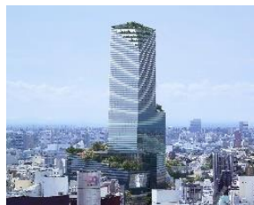
▶ Shibuya Upper West Project 2027年度竣工予定
