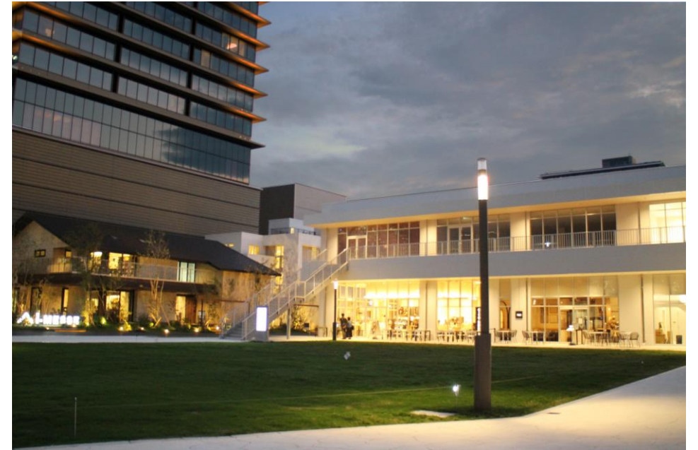
LIVINGTOWN みなとみらいに設置された「Secual Smart Pole」
