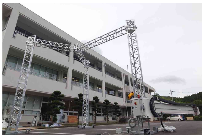
設置された建設用3Dプリンター
