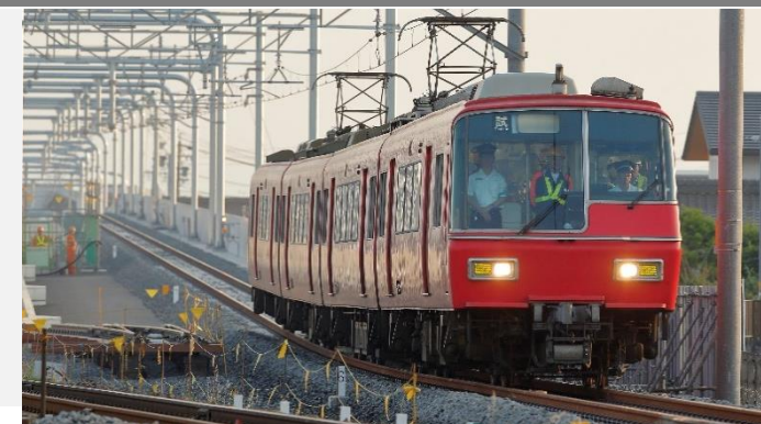
名古屋鉄道犬山線布袋駅本線軌道 (愛知県江南市)
