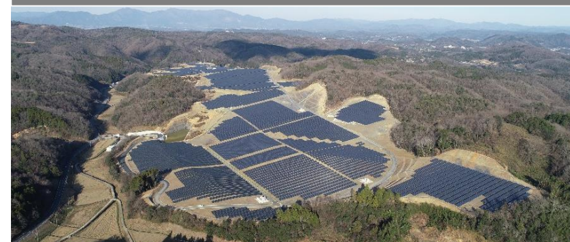
FBIT美咲発電所 (岡山県久米郡美咲町)
