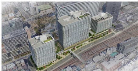
困町東地区第一種市街地再開発事業（JR・東京メトロ中野駅：施工中）
