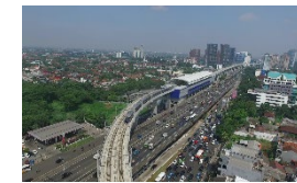
ジャカルタ大量高速輸送プロジェクト（インドネシア：2019年度竣工）
