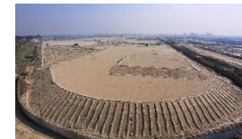
ダッカ都市交通整備事業6号線1工区の車両基地造成工事（バングラデシュ：2018年度竣工）
