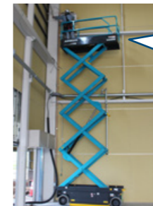
高所作業車の稼働現場
