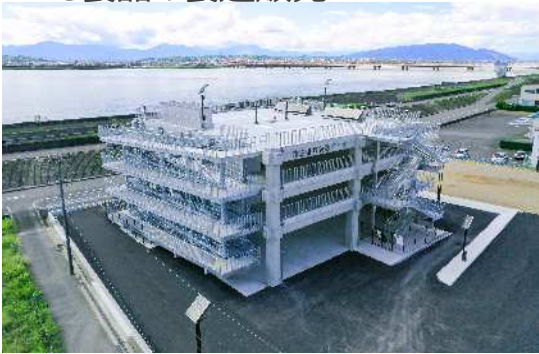
桑名市津波避難施設
