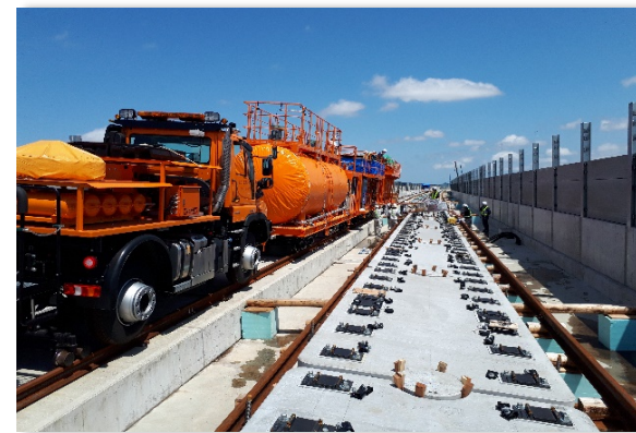
北陸新幹線 福井軌道敷設他工事
