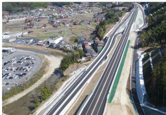
令和3年度安芸バイパス上瀬野地区第2舗装工事 (国土交通省中国地方整備局)
