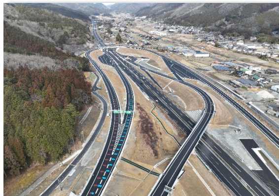
中国横断自動車道たつの舗装工事 (西日本高速道路株式会社)
