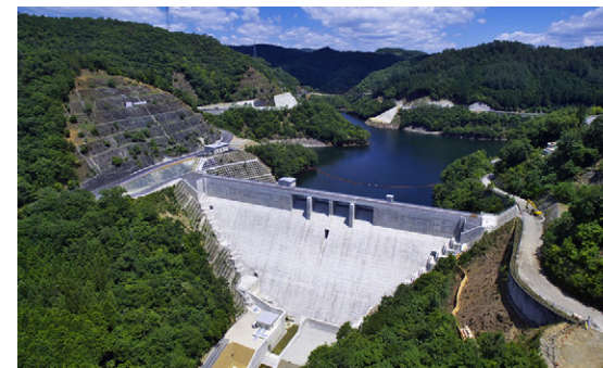
金出地ダム堤体
