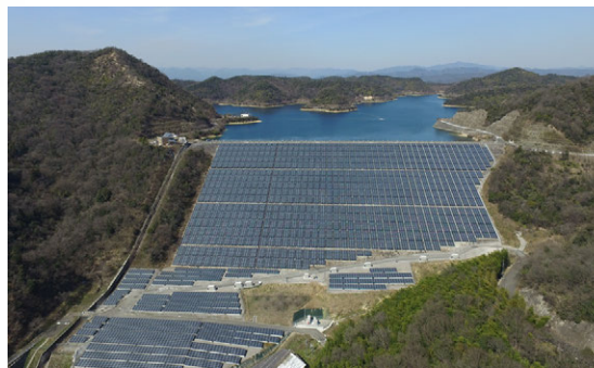
神谷ダム太陽光発電施設
