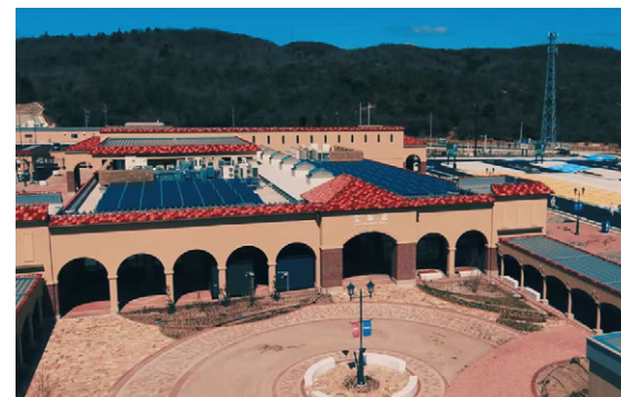
高速道路施設工事
