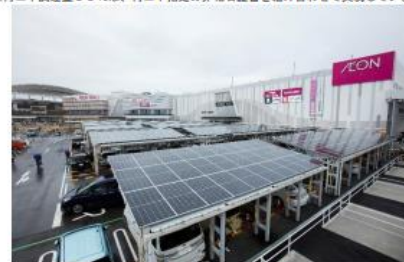
イオンモール豊川に設置したソーラーカーポート
