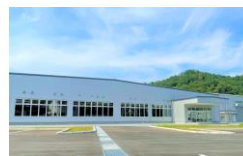
第4工場：深紫外レーザー増産
