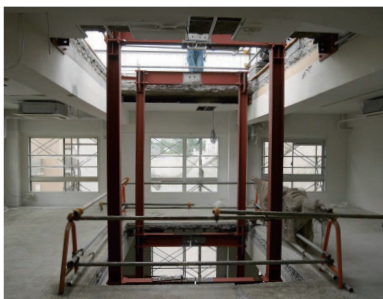
▲エレベーター新設
