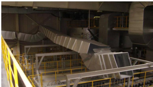
福島県いわき市内清掃センターの排気ダクト落下事例※1
