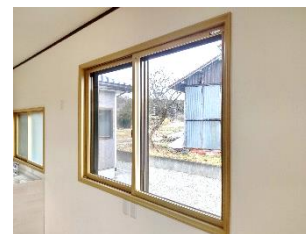
内窓の設置事例
