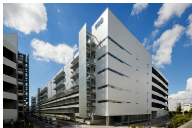
東京流通センターA棟
