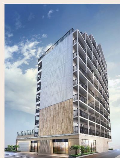
アルテシモ中野 2023年5月竣工
