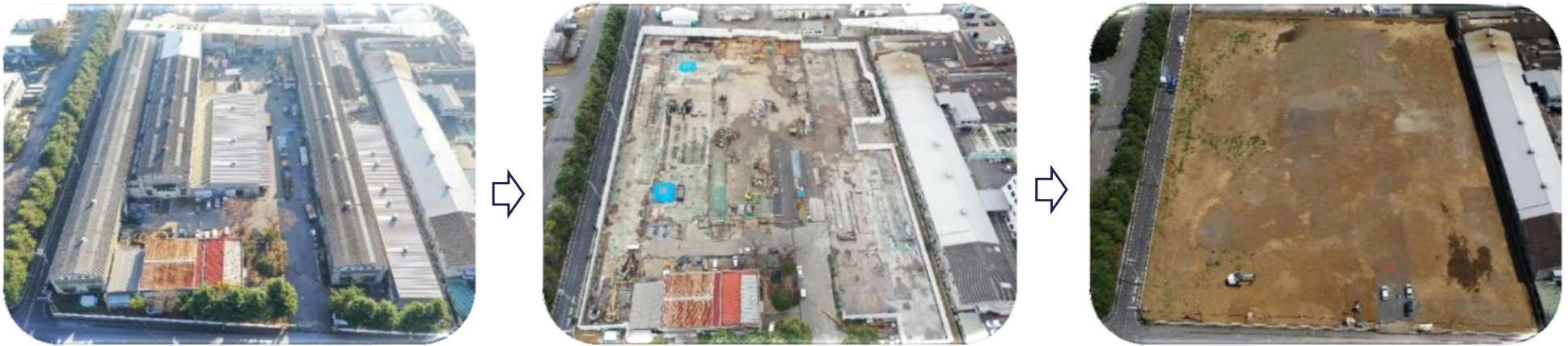
解体と土壌汚染対策を並行して施工した事例
