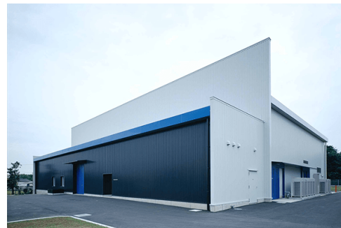
筑波計測センター
