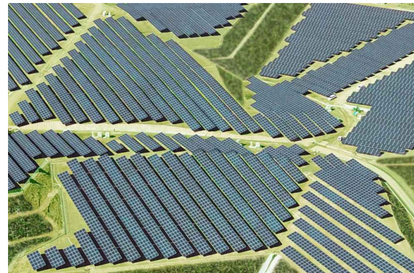
角田市太陽光発電所
