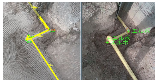
3D写真による導管工事図面の自動作成技術
