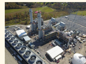
米国フェアビュー天然ガス火力発電所
