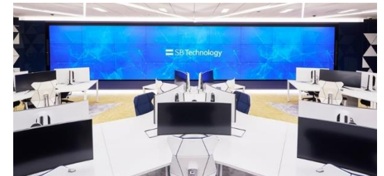
セキュリティ監視センター
