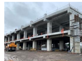
インド高速鉄道 Surat駅建設
