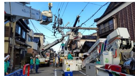
折損した電柱の改修
