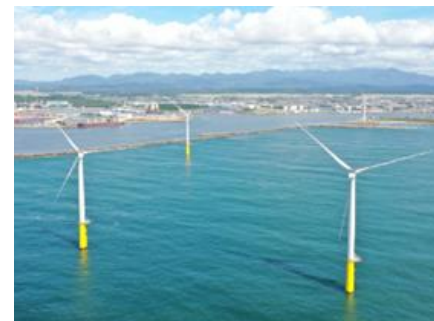
【秋田・能代港洋上風力発電所】 秋田県秋田市、能代市 出力計138,600kW (2023年1月 全面営業運転開始) (写真提供:秋田洋上風力発電株式会社)
