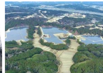
【パワープラント津波瀬】 三重県津市 出力35,000kW (2023年2月 営業運転開始)
