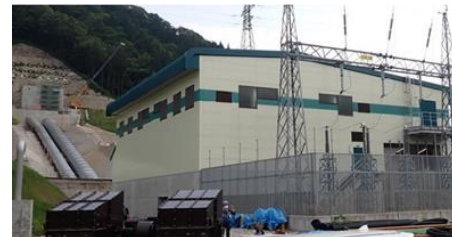
【玉川第二発電所(水力)】 山形県小国町 出力14,600kW (2022年11月 営業運転開始)
