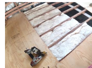
断熱材の設置事例
