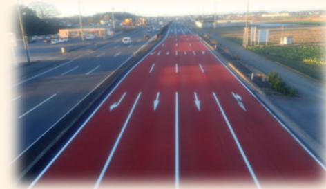
R2国分寺出張所管内路面補修工事 ＜高強度アスファルト混合物「ストロングファルト」施工＞
