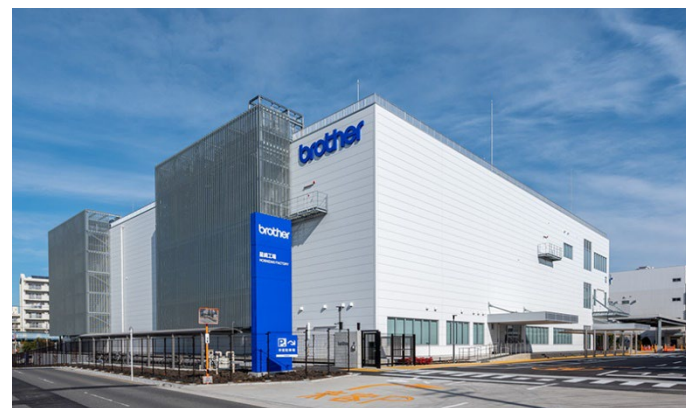
星崎工場 新工場棟（第13工場）
