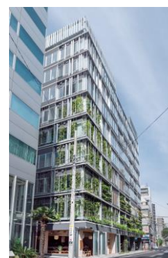
▲ T-PLUS 日本橋小伝馬町 (2022年4月竣工)
