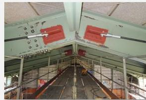
独自製品の耐震CB(ケーブルブレース)等、耐震補強材の開発・供給。
