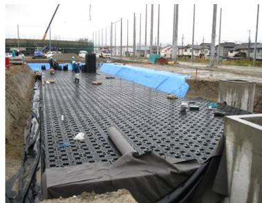
リ・タンスイシステムは、「ジオプールAE-1工法」を用いた当社の雨水貯留浸透施設です。近年、各地にみられる集中豪雨による河川の氾濫、都市型洪水の問題解決への一助になるものと考えております。また、製品のAE-1は、容器リサイクル法に基づく家庭ごみのプラスチック材を原材料として再利用しているため、エコマークを取得しており、環境保護にも寄与しております。
