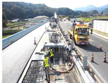
水のかで洗う、剥がす、削る、切るといった超高圧の水噴流を利用したウォータージェット工法は環境に優しく、繊細な作業性能と超高圧力が生み出す強靱なパワーを持った加工システムです。特に、既設コンクリート構造物に対するリニューアル工事では、従来工法と比べ、衝撃によるマイクロクラック、騒音および粉塵の発生を抑制し、また品質向上を図りインフラの長寿命化を実現いたします。
