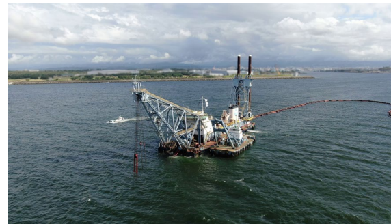
金沢港（大野地区）航路（-1.3m）浚渫外1件工事（石川県）
