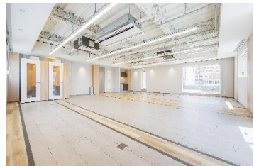
最上階の住居部分と1階駐車場の一部をオフィスにコンバージョン
