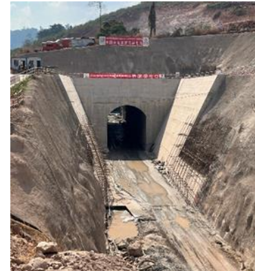
迂回トンネル
