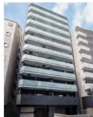
マンション施工事例
