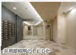
共用部照明のLED化
