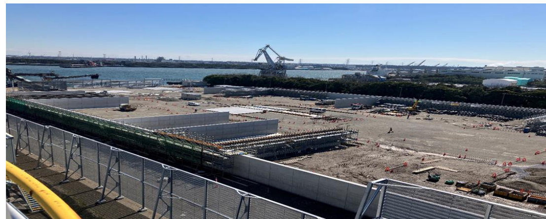
新設工事中的の南袖骨材ヤード（袖ヶ浦市）
