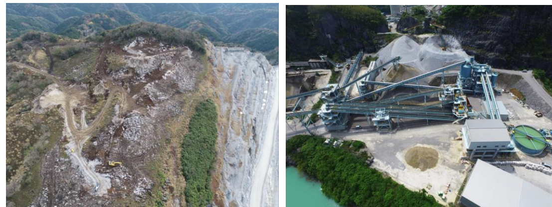
新津久見鉱山（表土除去工事中の八戸地区と水洗骨材プラント）
