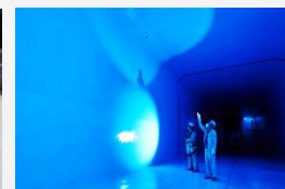
上下水道防水 施工例
