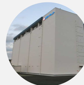
日向工場避難棟
