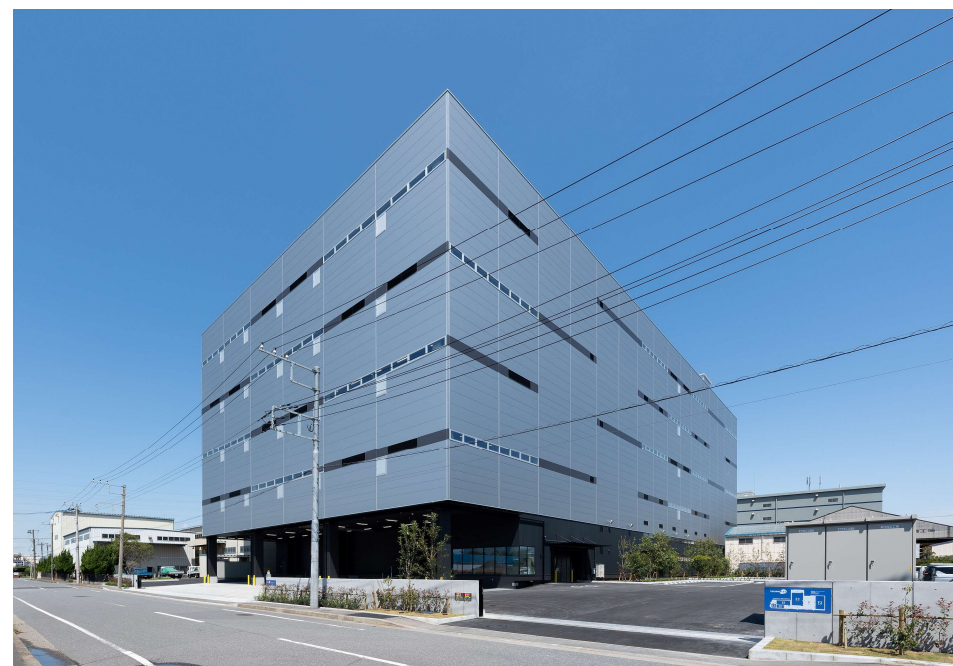
▲ 4月に竣工した新千葉工場(第1工場)
