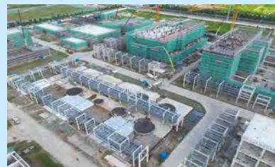
昨年の工事状況
