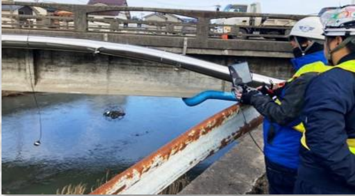
屋内点検用ドローン(ELIOS 3)による橋梁点検
