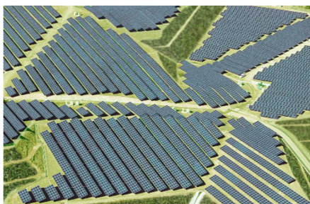
（角田市太陽光発電所）
