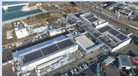
石巻工場 2023年3月稼働 400kW 年間200t-CO2削減
