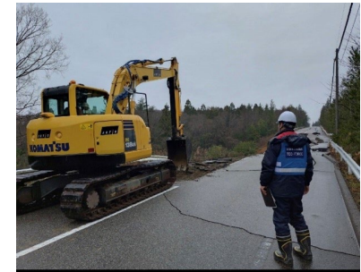
能登半島地震緊急復旧（道路啓開）
