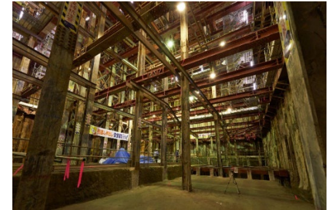
渋谷駅街区土地区画整理事業に伴う 渋谷駅東口基盤整備工事(第一工区)
