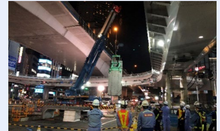
R2国道246号渋谷駅周辺地 下道工事
