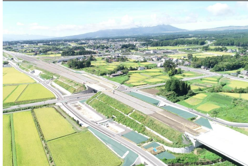
新東名高速道路御殿場インターチェンジ工事 (静岡県)
