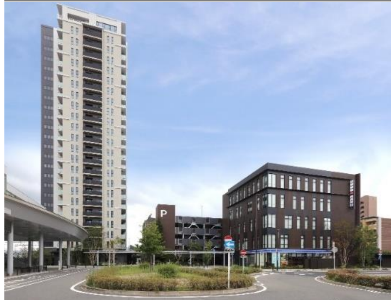
プラウドタワー春日井 (愛知県春日井市)
