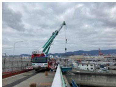
神戸空港連絡橋上部工(拡幅部)製作・架設工事 MMB・宍神建設JV 神戸市
