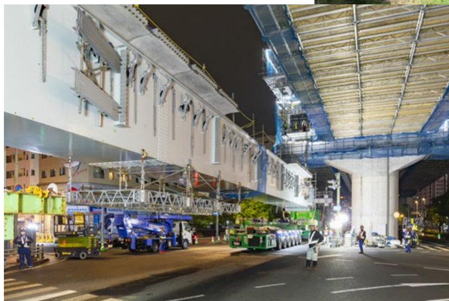
佐世保高架橋拡幅工事 西日本高速道路株式会社
