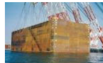
南本牧鋼製ケーソン
