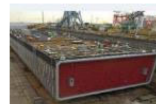
東京港海の森トンネル沈埋函
