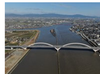
有明筑後川大橋
