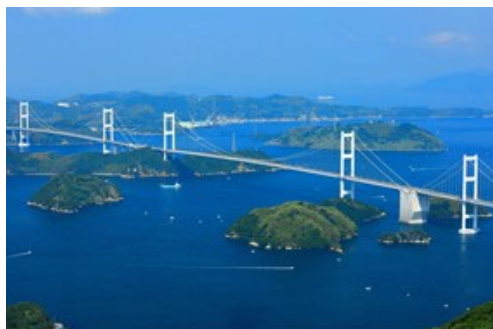
来島海峡第二大橋
