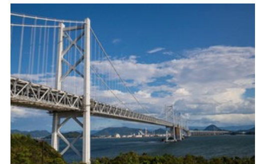
北備讃瀬戸大橋・南備讃瀬戸大橋
