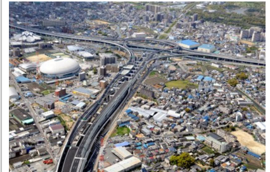
第二京阪道路 門真高架橋東(鋼上部工)設計・工事
