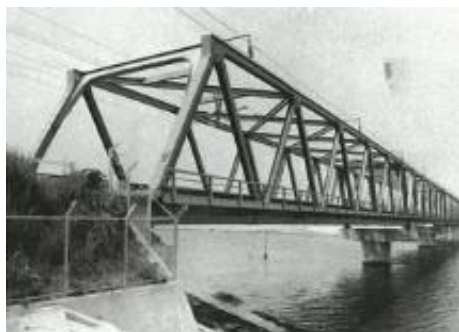
東海道新幹線江川橋梁
