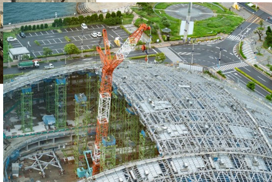
新香川県立体育館鉄骨工事 株式会社大林組他JV
