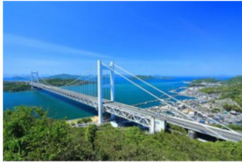
下津井瀬戸大橋
