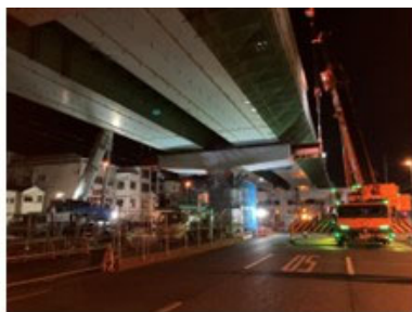
港川付近鋼製橋脚等大規模更新工事 MMB・森組JV 阪神高速道路株式会社
