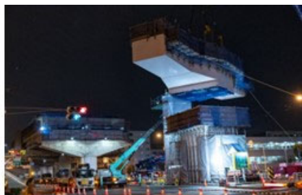
喜連瓜破大規模更新工事 大成・富士ビーエス・MMB異工種JV 阪神高速道路株式会社
