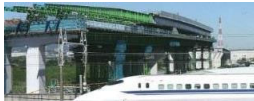
東海道新幹線50K900付近さがみ縦貫道路16号橋
