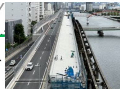
高速1号羽田線(東品川棧橋・鮫洲埋立部)更新工事 大林・清水・三井住友・東亜・青木あすなる・ 川田・東骨・MMB・宮地異工種JV 首都高速道路株式会社
