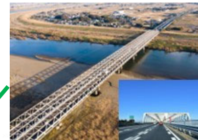
東北自動車道 利根川橋耐震補強工事 エム・エムブリッジ株式会社・鉄建建設株式会社JV 東日本高速道路株式会社
