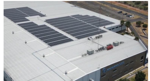
メキシコ子会社の屋上ソーラーパネル
