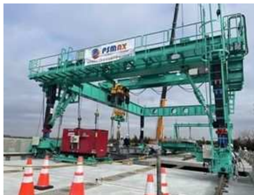
低空頭タイプ 床版撤去架設機
