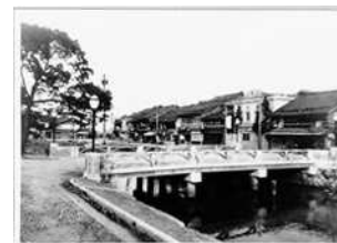
長生橋（石川県七尾市）
