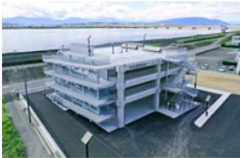
桑名市津波避難施設
