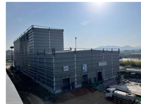
中国子会社 工場増設・改修工事の様子
