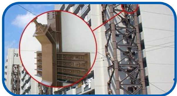
建物の耐震補強に・・
