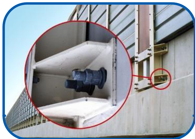
高速道路の防音壁に・・
