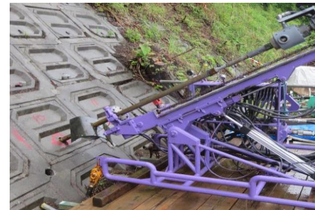
ホーク・ネイリング工法
