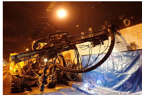
ロックボルト補強工事
