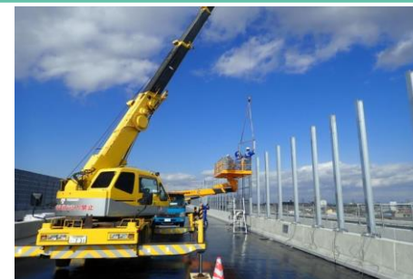
名古屋第二環状自動車道 名古屋西JCT～飛島JCT間遮音壁工事
