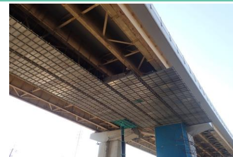
中央自動車道 土岐IC～小牧東IC間 コンクリート構造物補修工事
