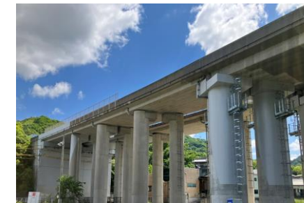
国分寺高架橋他5橋耐震補強工事
