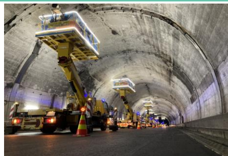
山陽自動車道 尼子山トンネル 覆工背面応急復旧工事
